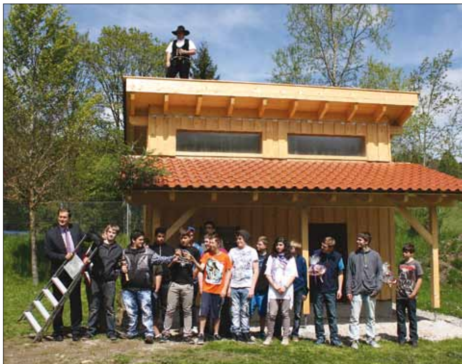
Richtfest feierte 2013 die neue Hütte auf dem Jugendzeltplatz. FOTO: SJR
