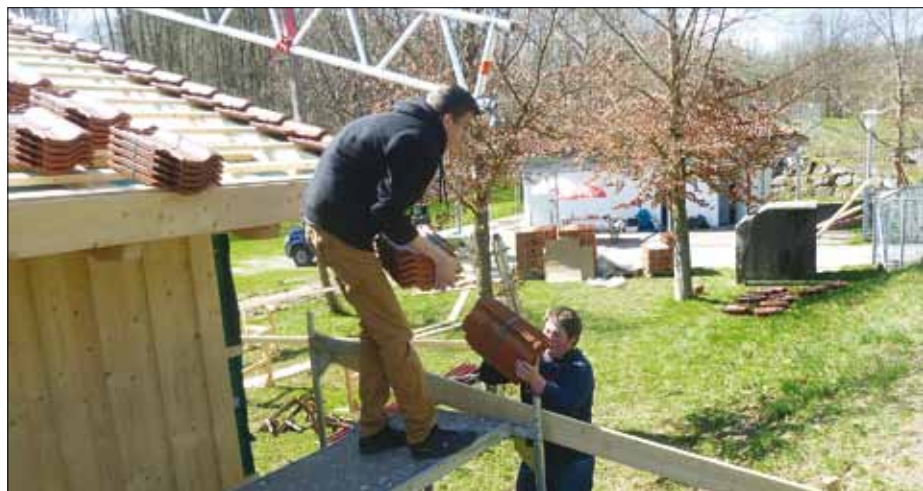
Das Dach der „Hütte“ auf dem Jugendzeltplatz wird gedeckt. FOTO: SJR
