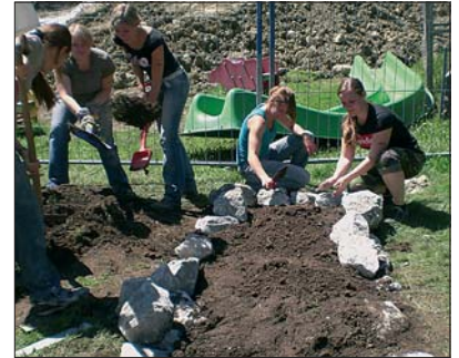
Das Fundament für die Trockenmauer entsteht.
